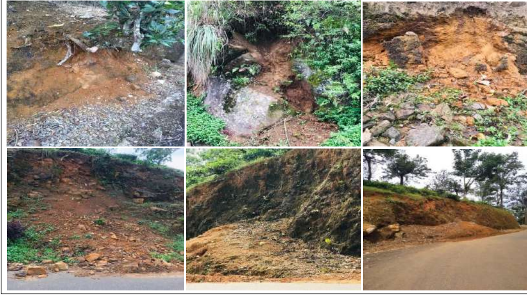
ஒளிப்படம் 9 : ஆய்வுப் பிரதேசத்தில் அவதானிக்கப்பட்ட மண்ணரிப்பு, சாய்வு இழப்புக்கள் மூலம் : ஆய்வாளர், 2024
