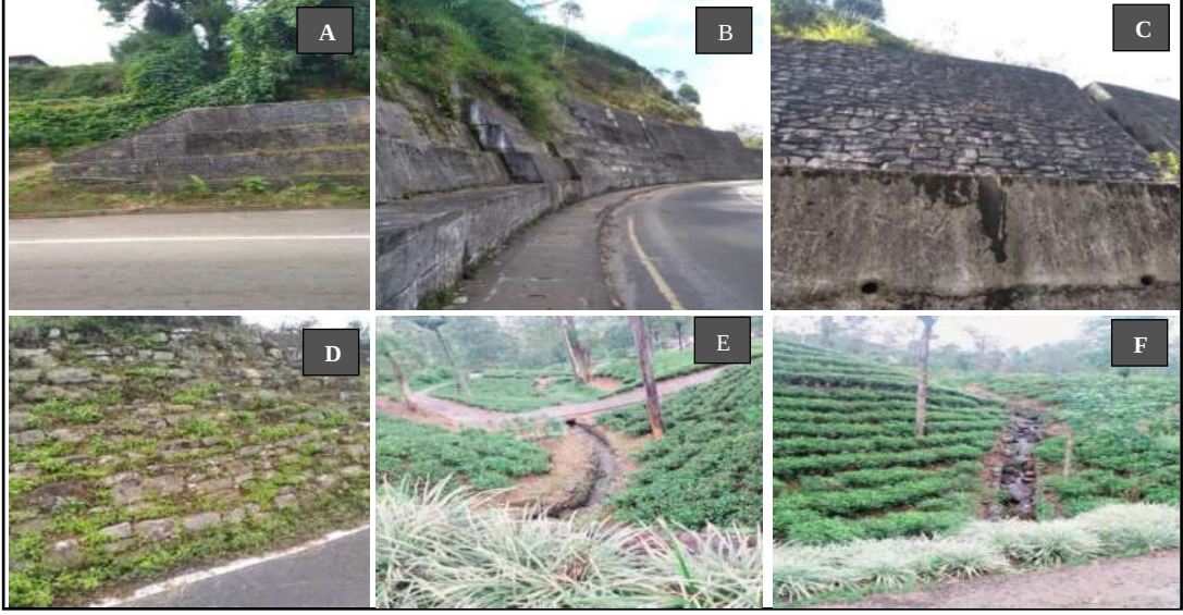
ஒளிப்படம் 1 : ஆய்வுப் பிரதேசத்தில் சாய்வுப் பாதுகாப்பு முறைகள் - A: ஆய்வுப்பிரதேச கேபியன் அணைகள், B , C: கொங்ரீட் சுவர், D:கற்கட்டடங்கள், E , F: முறையான வடிகால் அமைப்பு (மூலம் : ஆய்வாளர், 2024)
